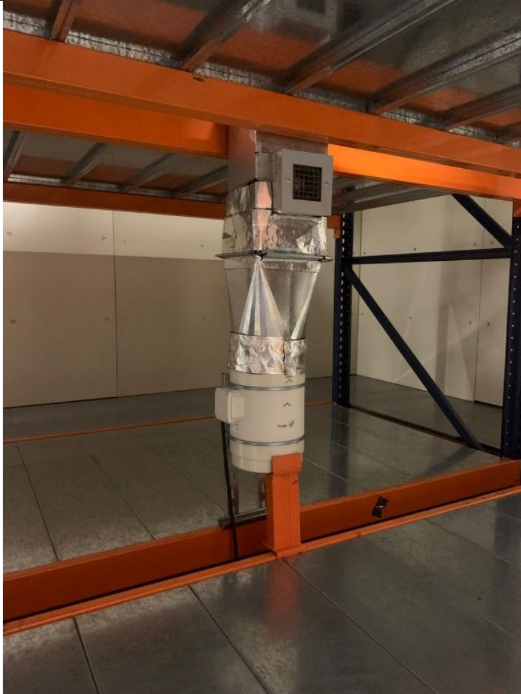
EQUIPOS HELICOCENTRIFUGOS (SOLER PALAU depósitos)
